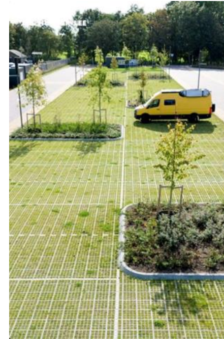
Automobilių stovėjimo vietos su vandeniui laidžia danga
