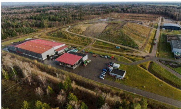
19 pav. Panevėžio regioninis sąvartynas
