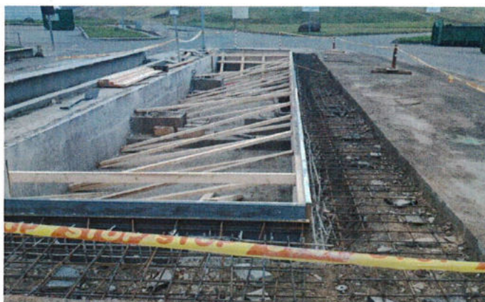
28 pav. Automobilinių svarstyklių pamatų remonto darbai
