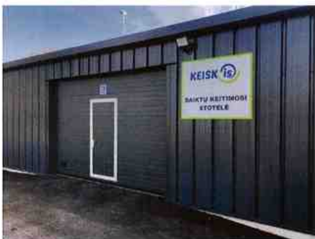
31 pav. Kėdainių g. 13;15, Panevėžys, įrengta DGASA
