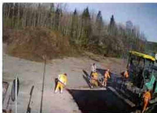
23 pav. Kelio remontas sąvartyno teritorijoje
