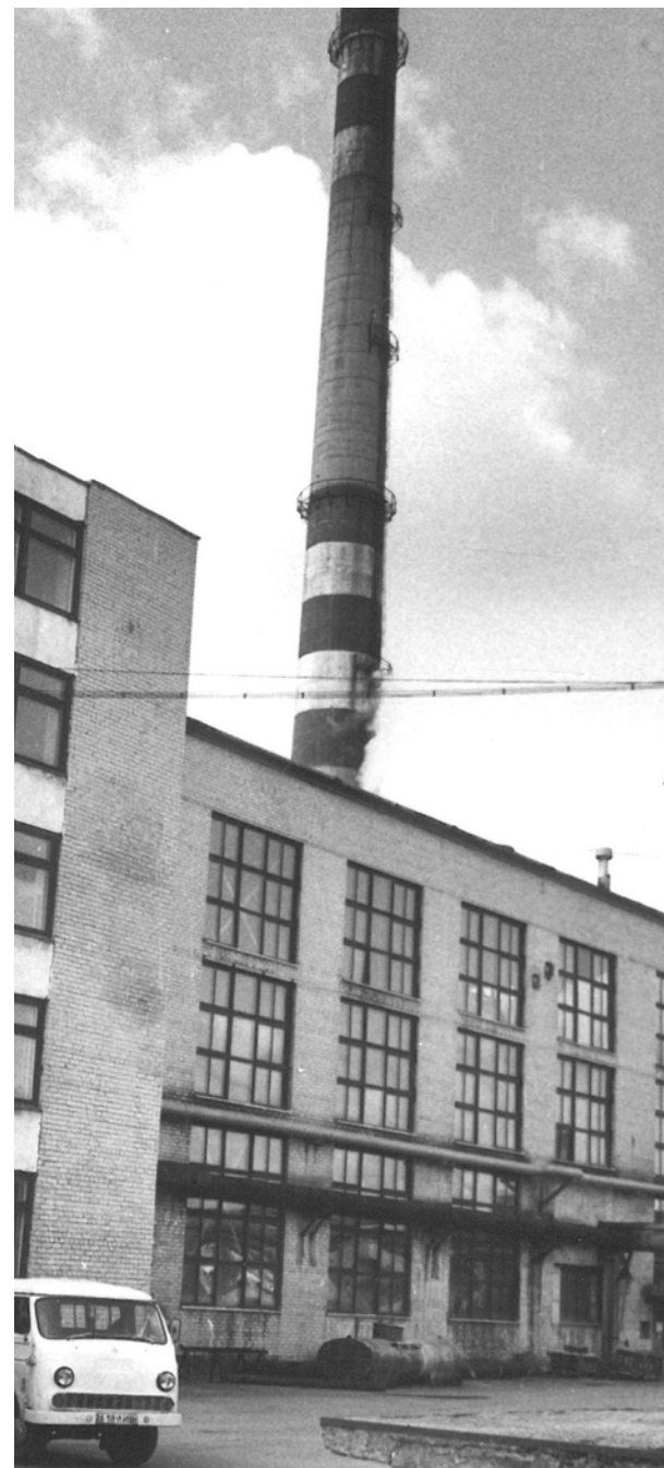
(archyv. Panevėžio rajoninė katilinė Nr. 2, dabar - Panevėžio elektrinės katilinė)
