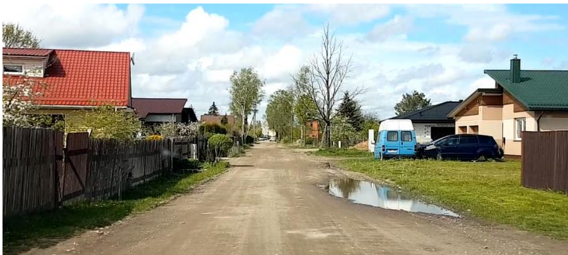
3 pav. Esama gatvės danga, PK 4+00 – PK 8+20
