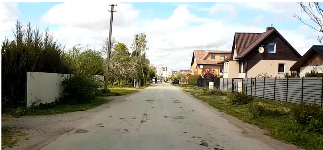
2 pav. Esama gatvės danga, PK 0+00 – PK 4+00
