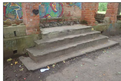
Blogos būklės betoniniai laiptai demontuojami, įrengiami nauji, analogiški LP-1, laipto matmenys 36x12 (h) cm
