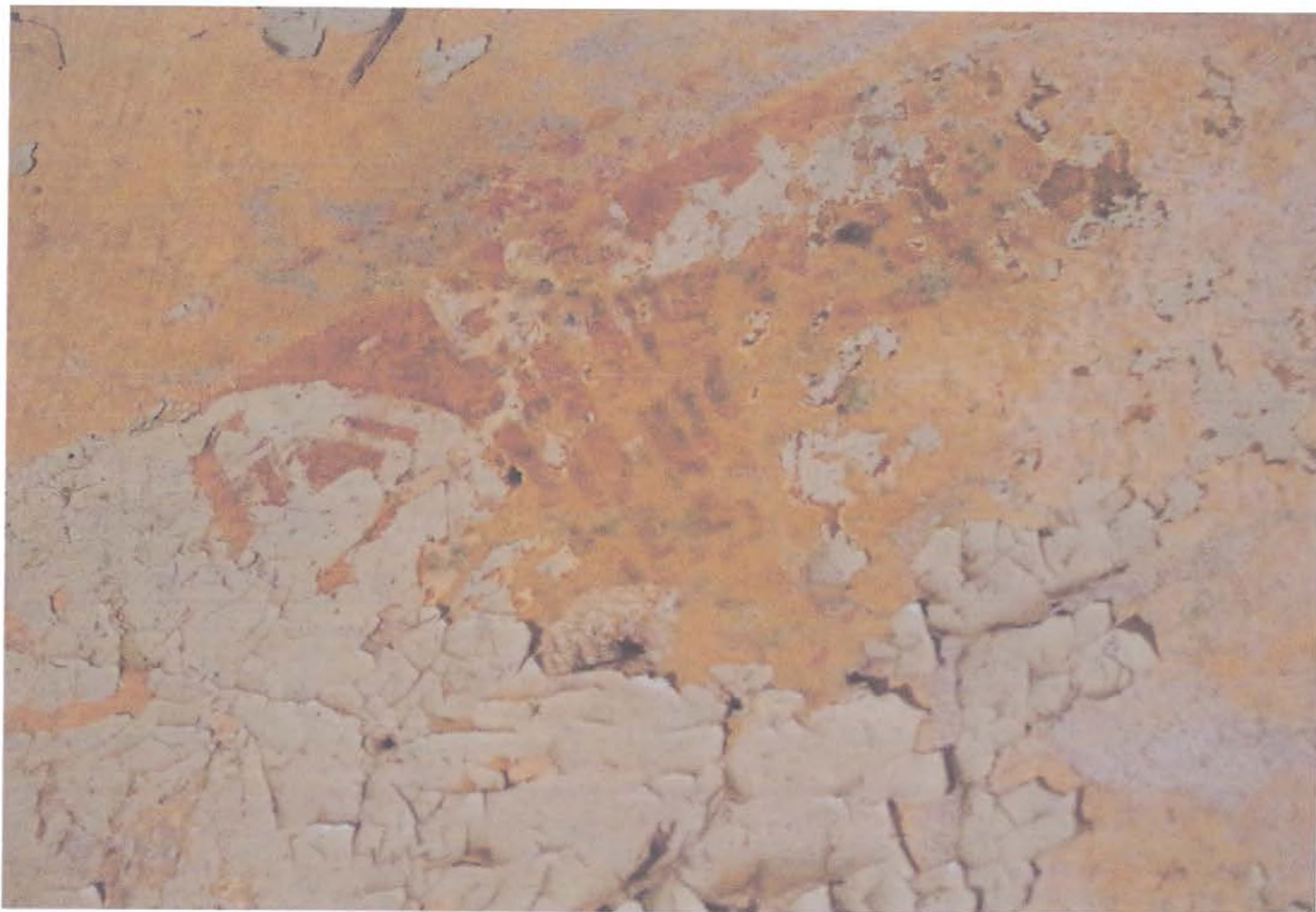
Fot. 19 Patalpa Nr. 9 (laiptinė, pirmas aukštas)
