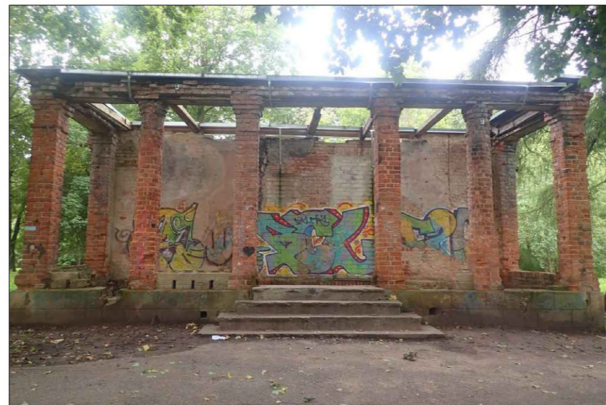
Esama rytinio fasado vaizdas. Terasos galinės sienos tinkas nėra objekto vertingoji savybė, todėl tinkas šalinamas ir atidengiama objekto vertingoji savybė "fasadų apdaila ir puošyba - raudonų plytų mūras". Restauruojami atkuriant turėklai su lieto betono baliustromis, remontuojamas rustuotas cokolis ir plytų mūro fasadas (keičiamos pažeistos plytos, restauruojamos plytų siūlės).
