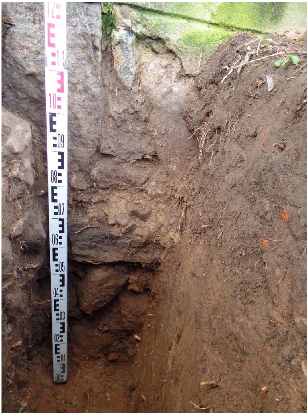
Šūrfas Nr. 1. Sodybos pastato pamatų pjūvis (fotografuota iš Š) 6
