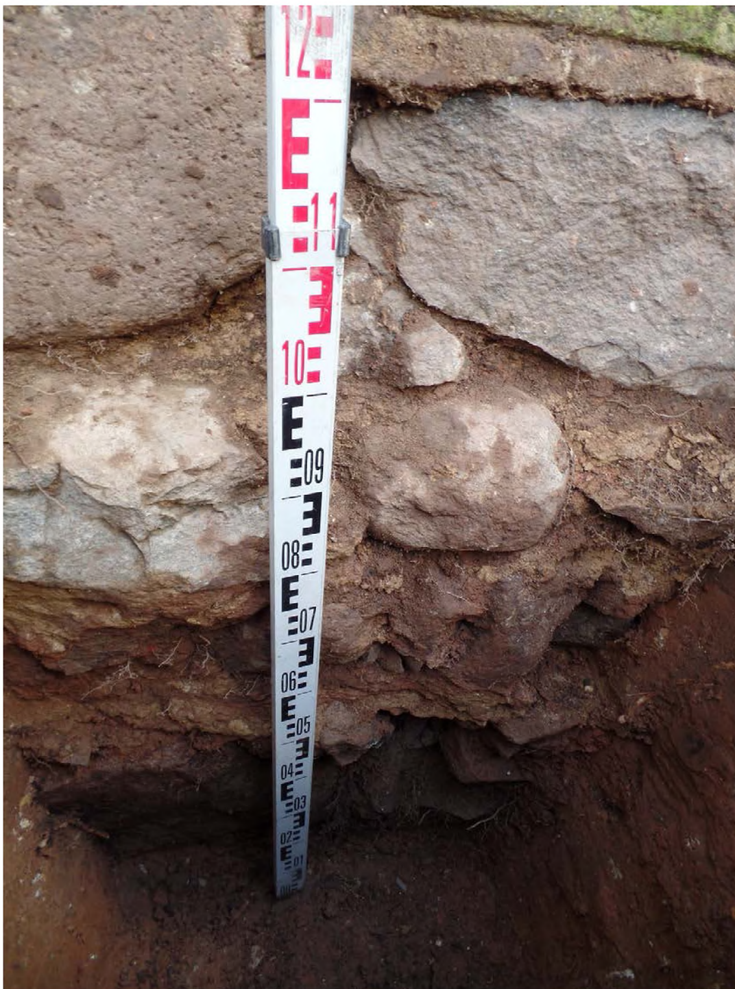
Šūrfas Nr. 2. Sodybos pastato pamatų pjūvis (fotografuota iš Š) 11
