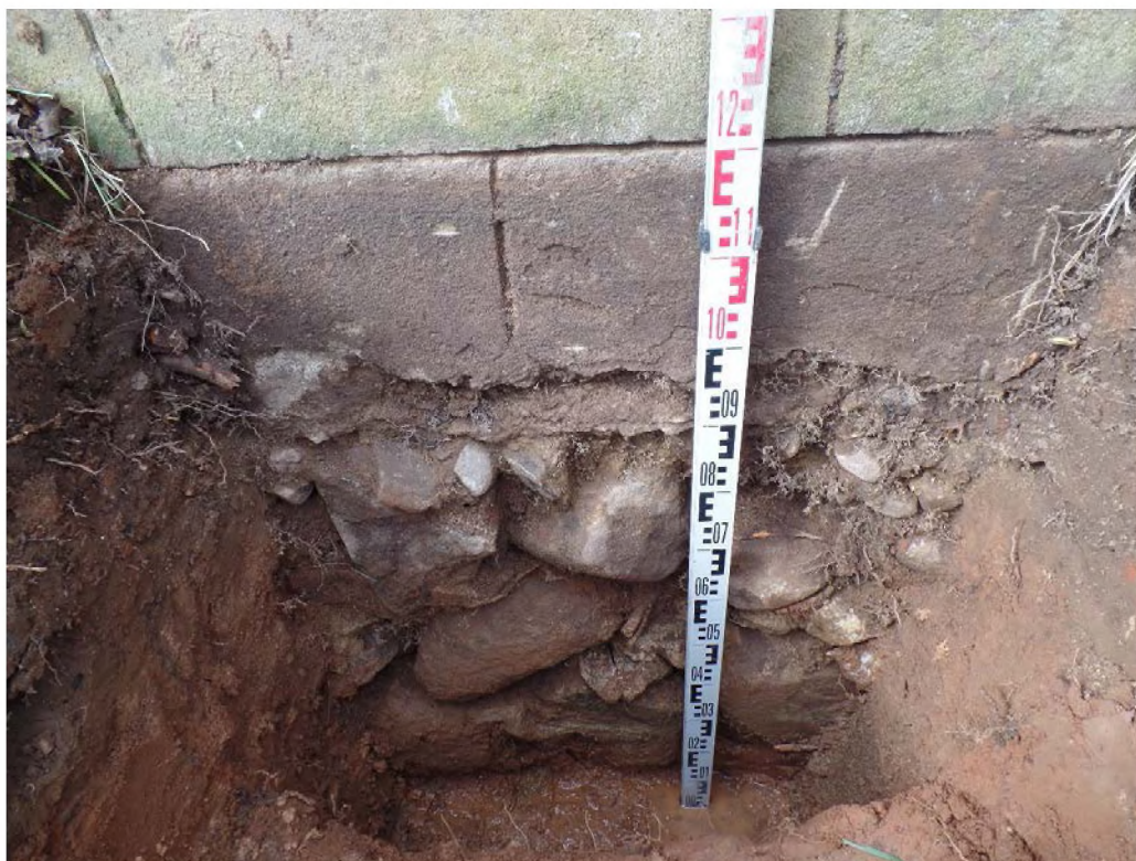
Šūrfas Nr. 3. Sodybos pastato pamatų pjūvis (fotografuota iš P) 16
