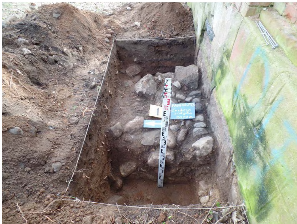
Šūrfas Nr. 1. Kontraforso pamatų pjūvio fiksacija pasigilinus iki 0,8 m gylio (fotografuota iš V) 5
