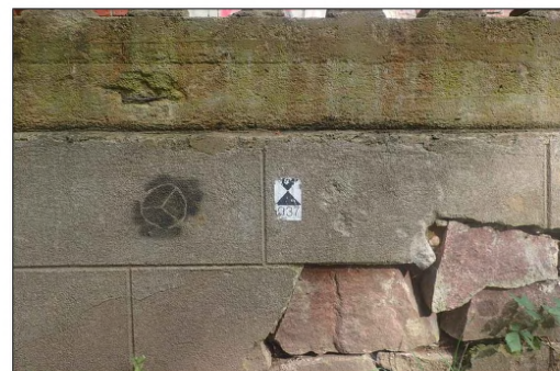
Cokolis mūrytas iš lauko riedulių ir skelto akmens, vėliau tinkuotas, formuojant rustus
