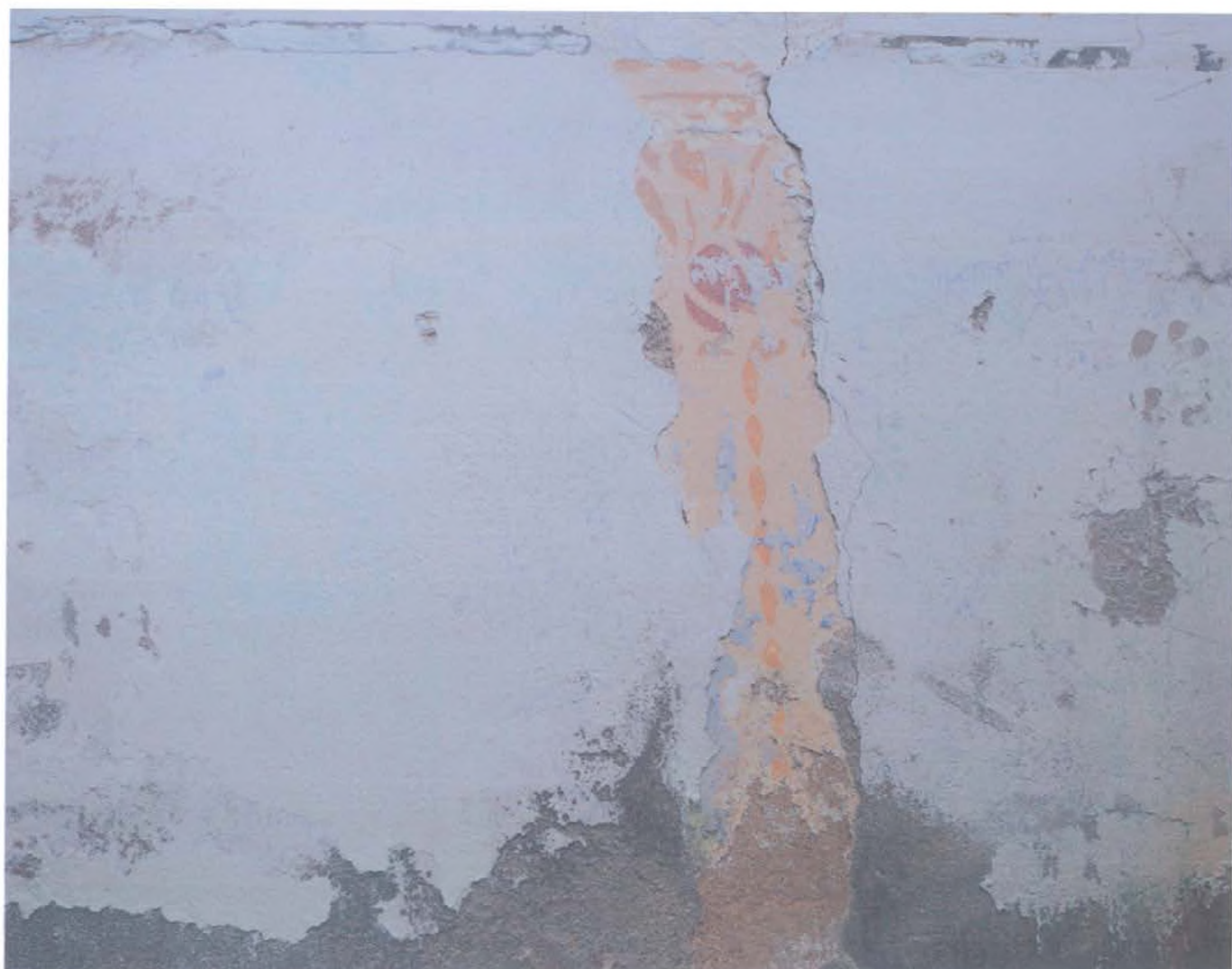
Fot. 4 Patalpa Nr. 4
