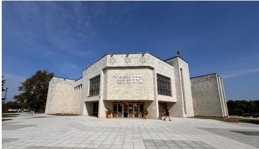
11 pav. Esama pagrindinės iškabos fiksacija
