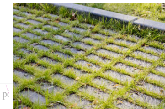
Betono trinkelų danga su vejos intarpais
