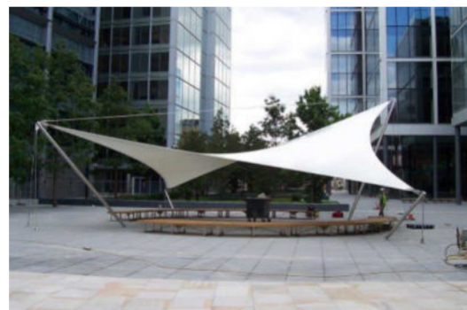
Membraninė įtempta stoginė, detalizacija B-07 brėžinyje
