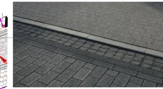
Važiujamosios dalies vandens surinkimo latakų trinkelės
