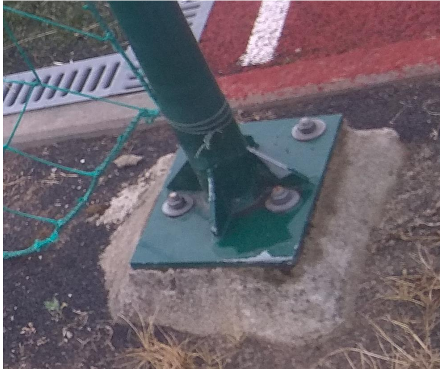
2 pav. Esamų stulpų tvirtinimo pamate fragmentas
