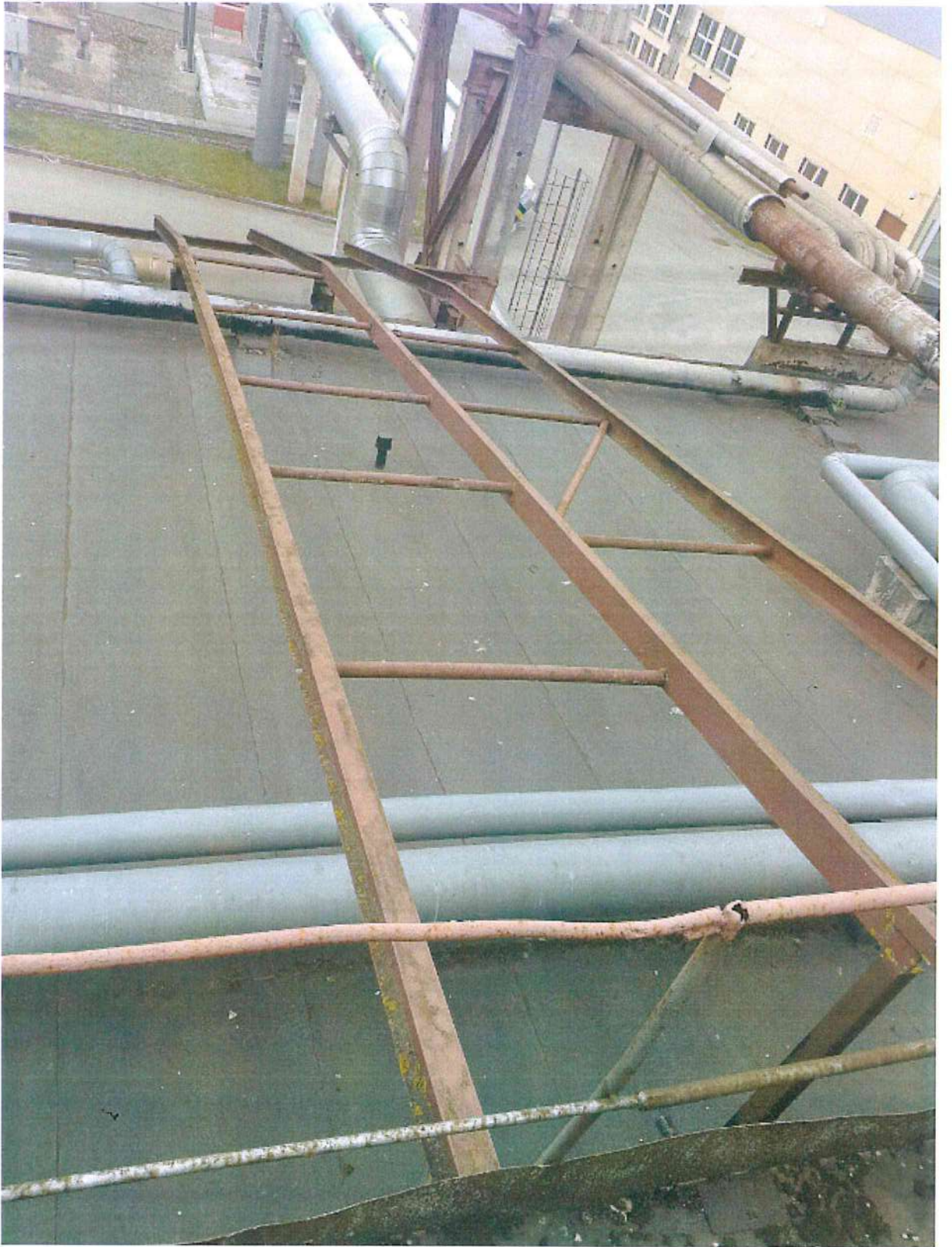
6 nuotrauka. Konstrukcijos medžiagų užkėlimui.
