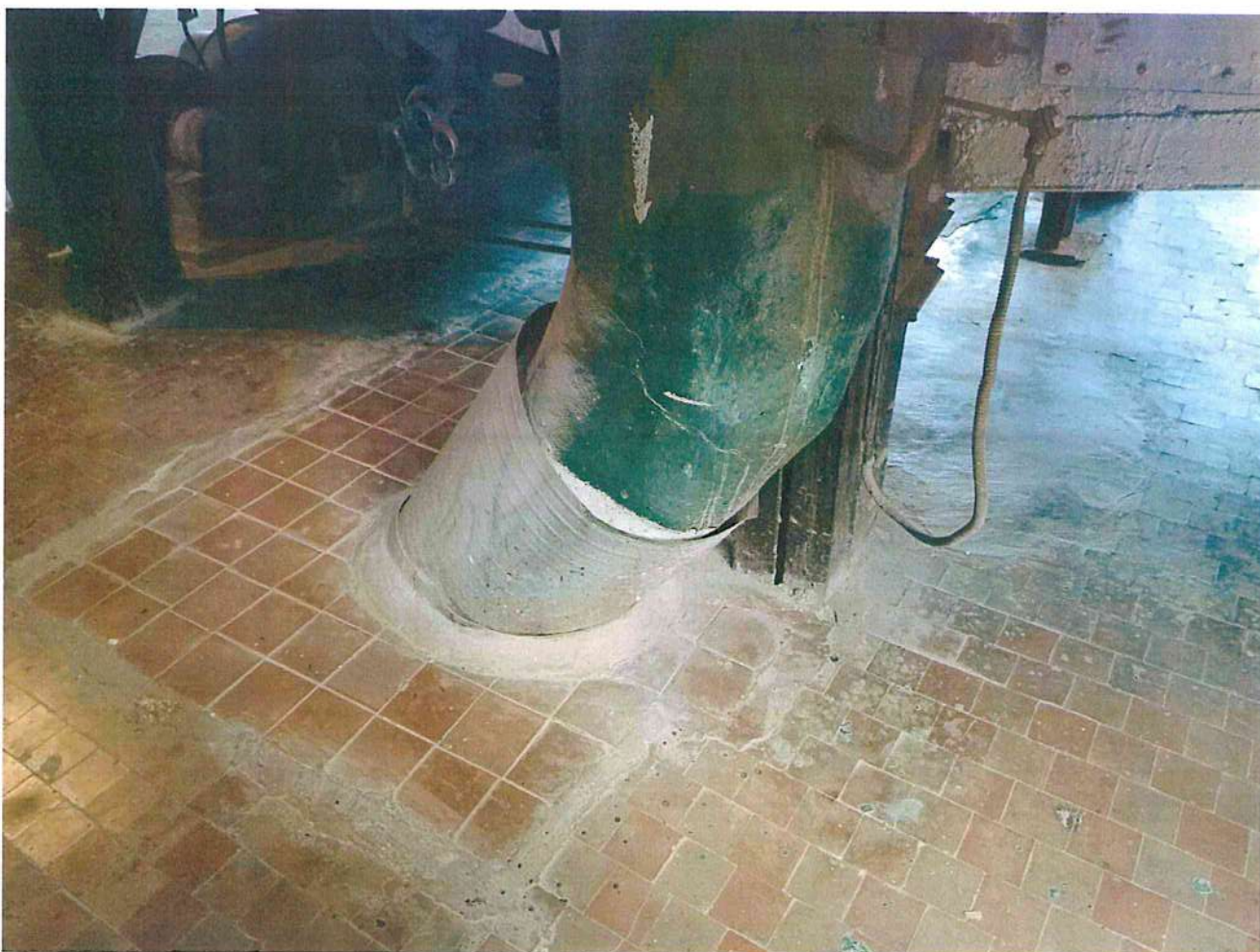
19 nuotrauka. Termofikacinio vandens po katilo vamzdžio anga grindyse.
